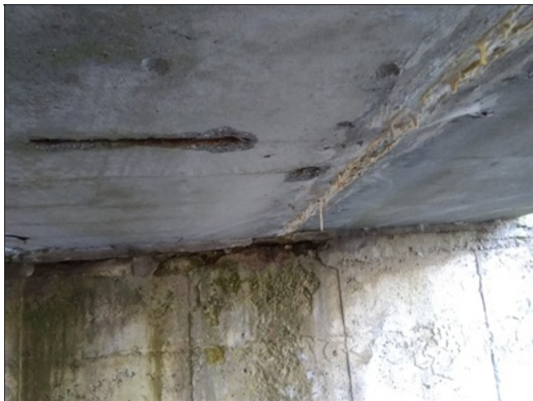
Poruchy v podhledu NK
