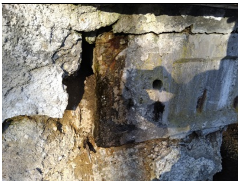
Rozpad opěry na výtakovém čele
