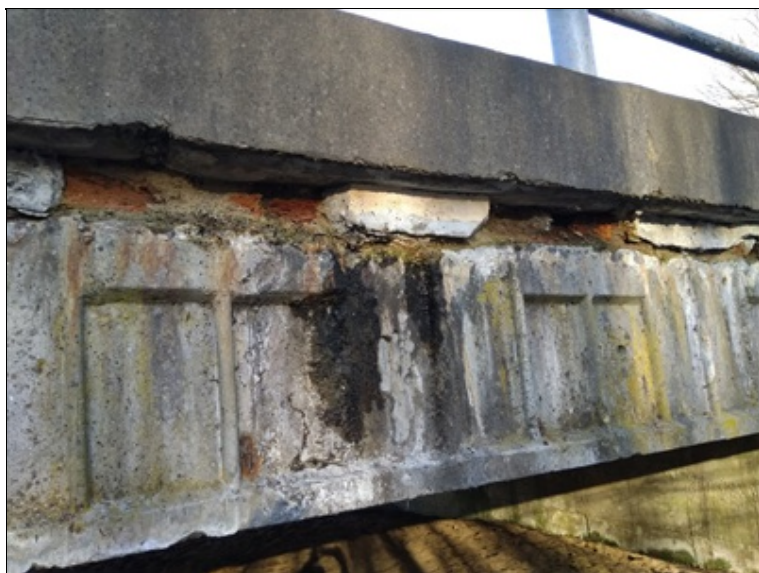
Rozpad podbetonování říms na výtakovém čele
